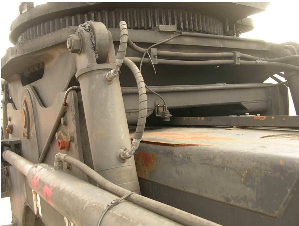
FOTO 3 - FRATTURA DEL CORPO SPREADER – N. 610
