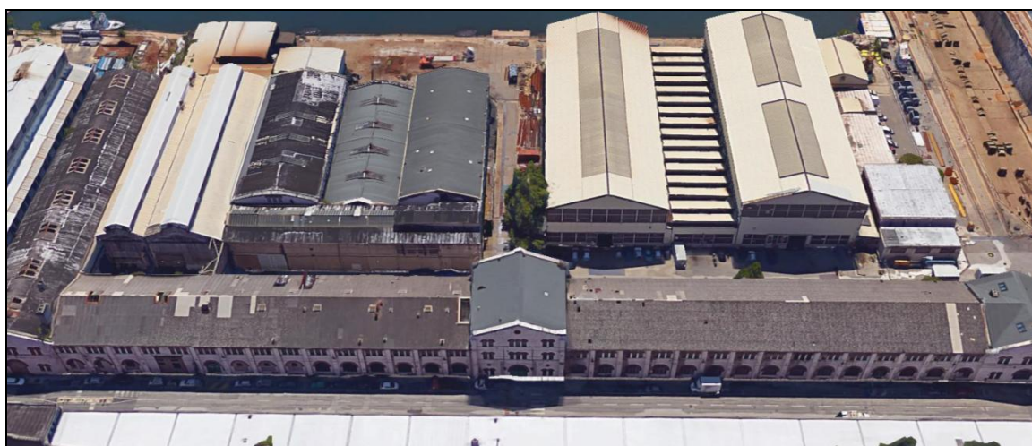
Figura 1: vista del fabbricato denominato ex magazzini 92 e 93
